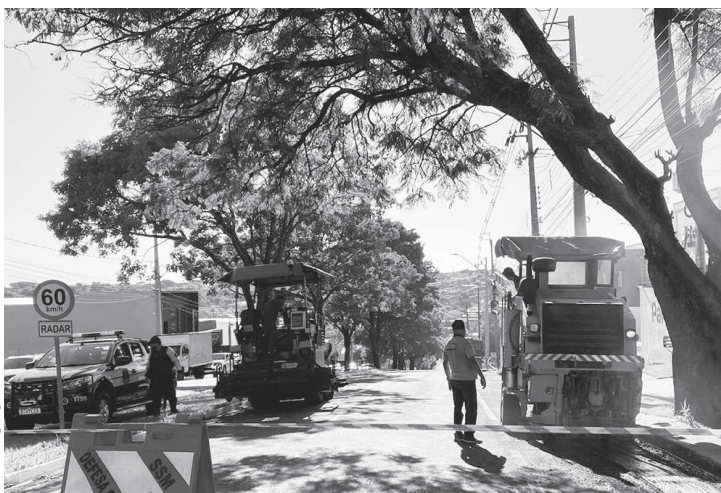
A intervenção ocorre após a identificação de desnível pontual no asfalto da via
