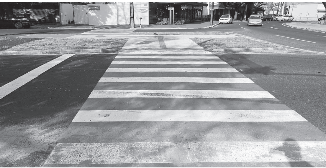
A obra está em 73% de execução
